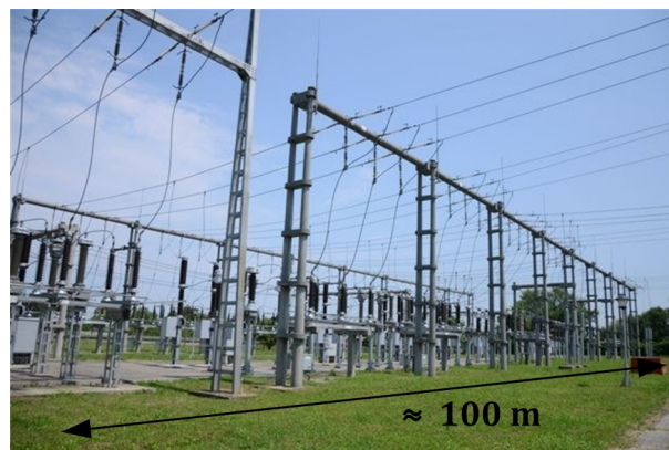
Слика 1.2. Дел од трафостаница за напон од 110 kV
