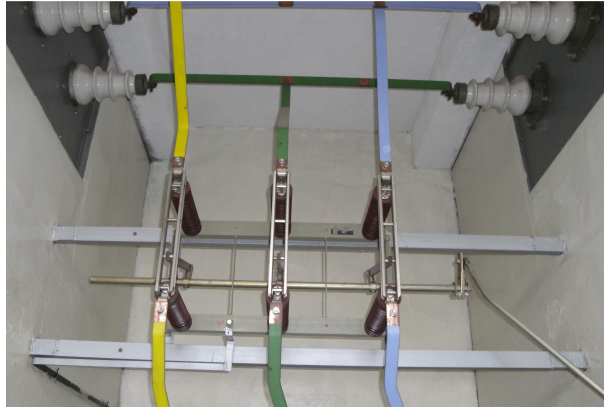
Слика 9.20. Воведни изолатори за премин од една во друга ќелија (во средината се гледа раставувач поставен на потрпони изолатори од вештачка смола)
