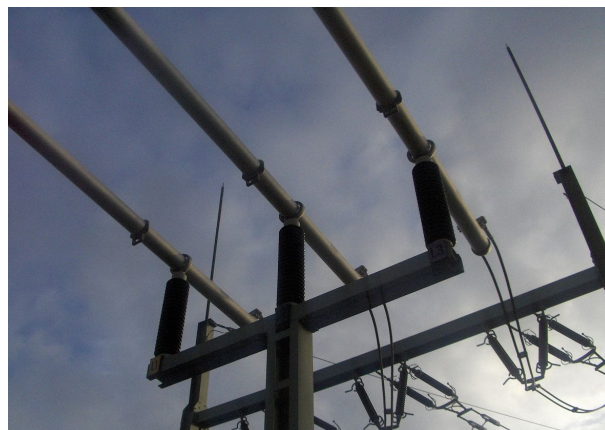
Слика 9.13. Потпорни изолатори за високонапонски собирници со форма на цевки
