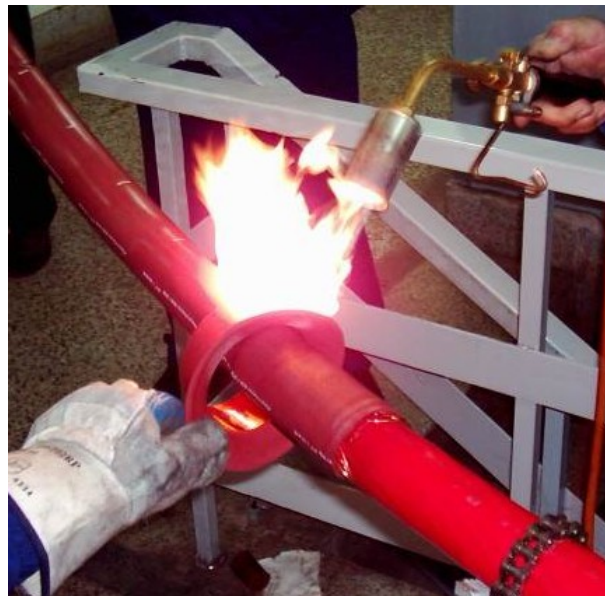
Слика 9.27. Монтажа на кабелски завршеток
