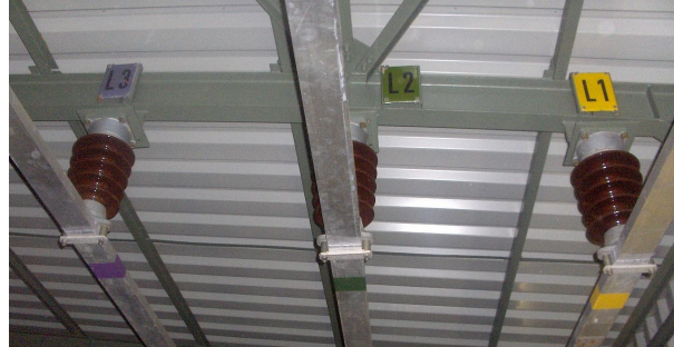
Слика 9.11. Потпорни изолатори за собирници поставени на таван
